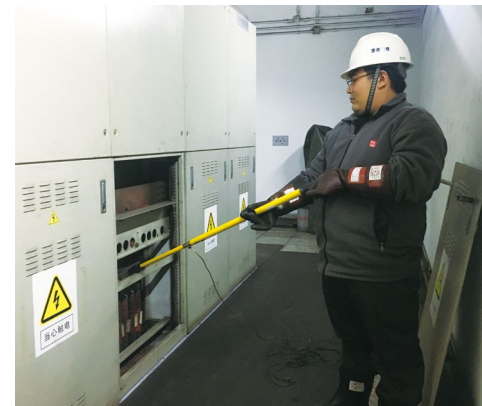
应用自主研发的直流验电器检测设备
