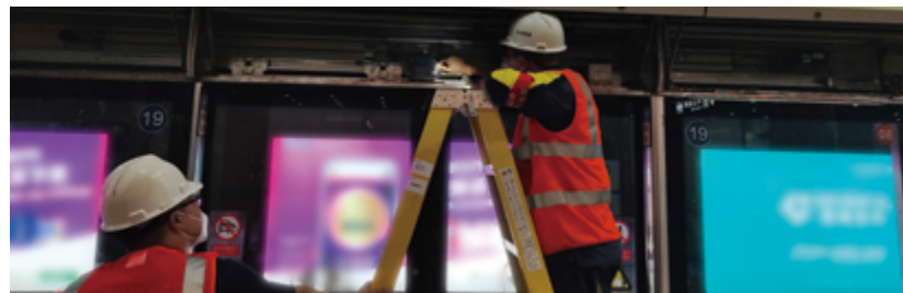
电磁锁线组维修现场
